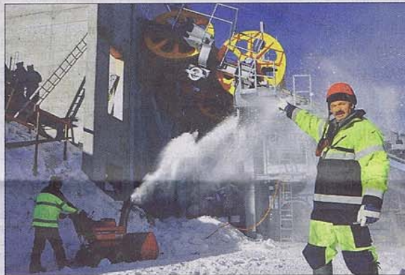
Bereits sind die Rollen für das Zugseil in der neuen Bergstation montiert.
